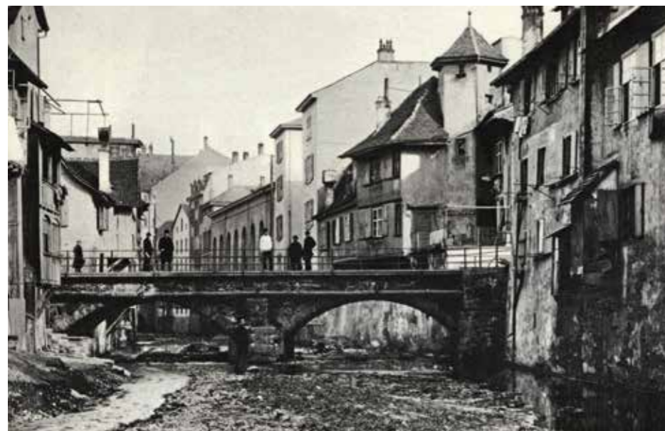
... und nochmals bei der damaligen Klosterbergbrücke.
